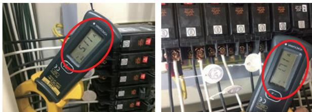
工事前（左）と工事後（右）で電流値が下がっています。
